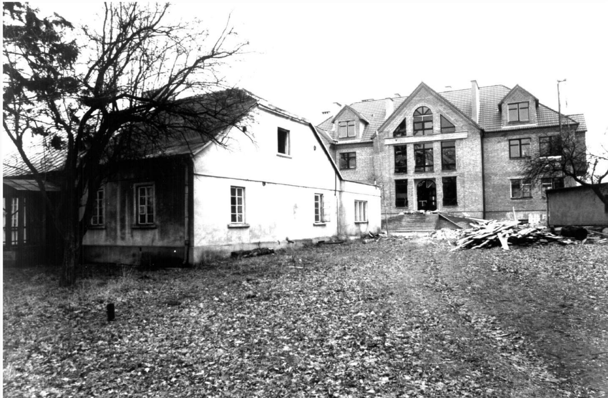
Stara plebania i budowa nowego Domu Zborowego Parafii ewangelicko-reformowanej – 1991
